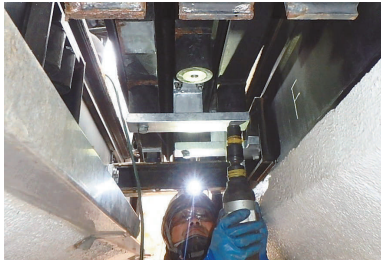
下面機構部品の取替え
