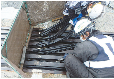
路面止水ゴムの取替え
