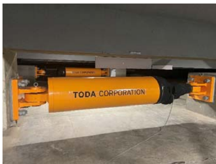
写真1 セミアクティブオイルダンパー
