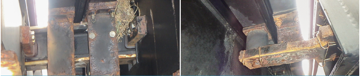
機構部品取替着工前
