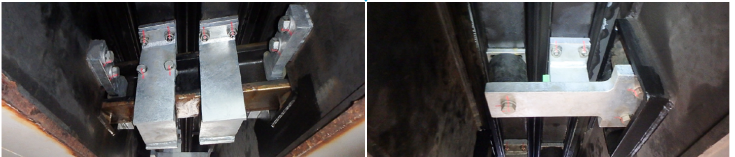
機構部品取替え完了
