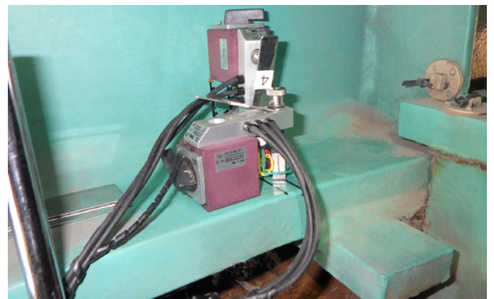
応力聴診器 設置状況
