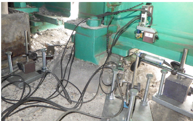
接触式変位計 設置状況
