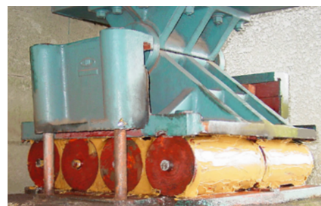
グリスアップ工法（ローラー部）
