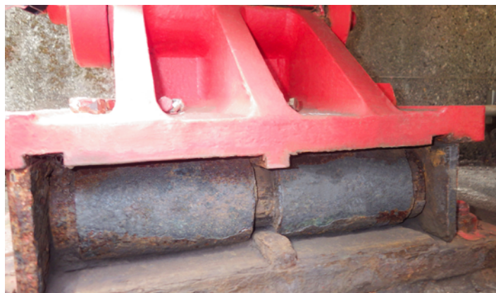
ピンローラー支承の点検
