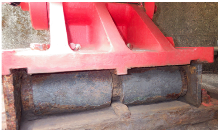
ピンローラー支承の点検
