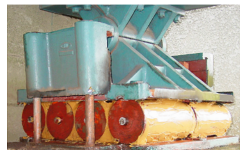
グリスアップ工法 (ローラー部)
