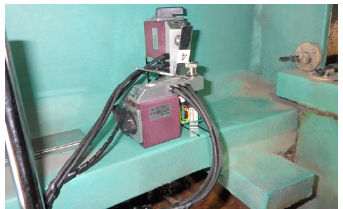
応力聴診器 設置状況
